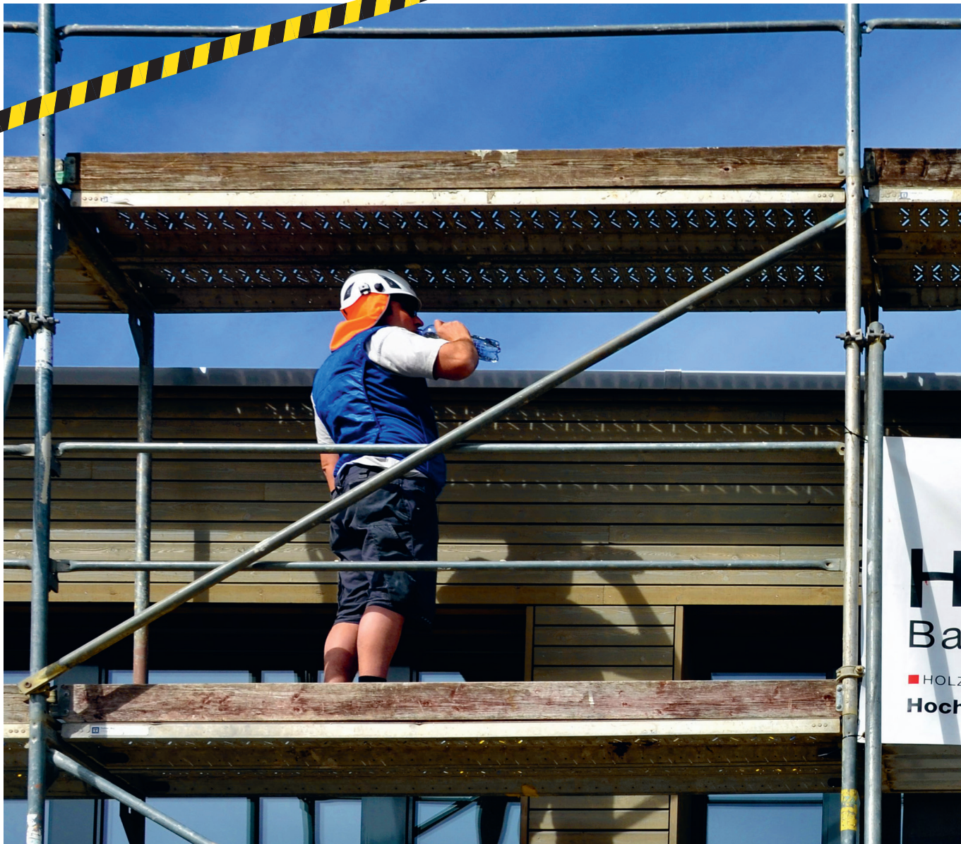
Bestens ausgestattet gegen Sonne und Hitze: Martin Huber, Zimmermann bei der Hochuli Schlossrued AG, trägt einen Nackenschutz am Helm und eine Kühlweste. Ein schattiger Arbeitsplatz und das ausreichende Trinken von Wasser helfen ihm zusätzlich bei grosser Hitze. Körperstellen, die nicht bedeckt sind, werden mit Sonnencreme gegen UV-Strahlung geschützt.
