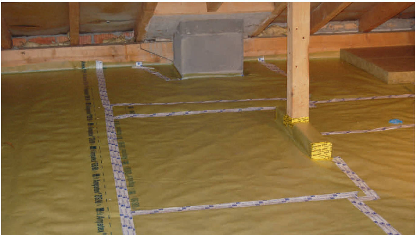
1. Die Luftdichtigkeitsfolie (Dampfbremse) wird vollflächig verlegt. Die Folienstöße und Randanschlüsse werden luftdicht abgeklebt.
