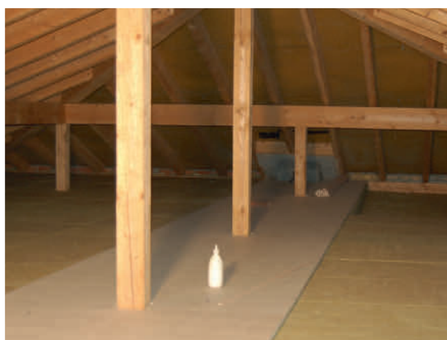
3. Der Spanplattenboden wird schwimmend auf die Dämmung verlegt.
