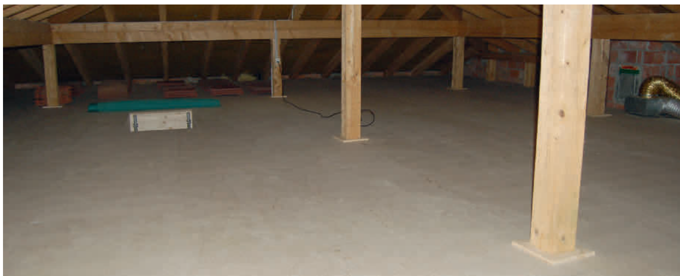
4. Die Arbeiten sind abgeschlossen. Der Estrich ist bezugsbereit.
